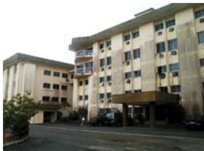
Façade de la DGS
